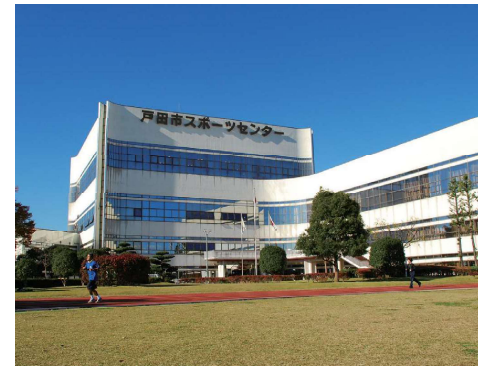
大規模改修が延期されたスポーツセンター
